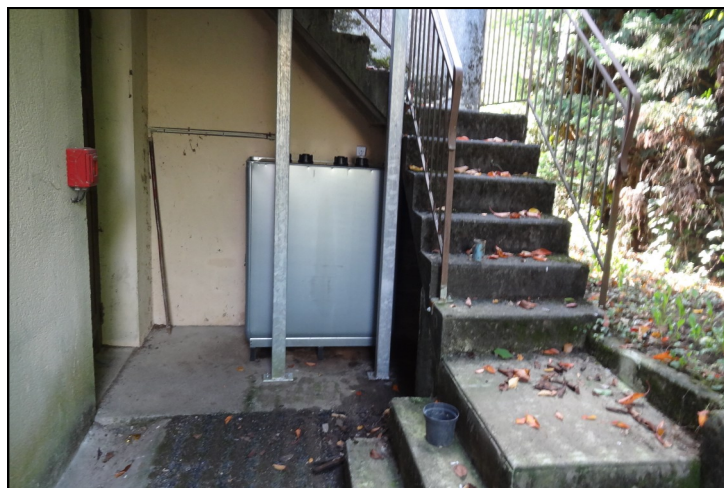
La cuve à fuel de la salle des fêtes a été remplacée
